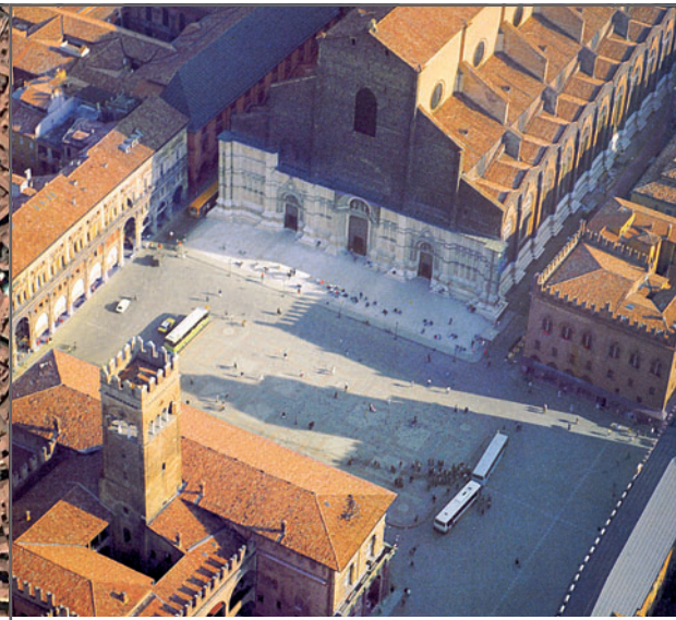
10 0 metri - Qui parte il sentiero che vi porterà dal centro di Bologna, fino ai confini più estremi dell'Universo visibile. Il nostro punto di partenza è a 100 metri di altezza su Piazza Maggiore.
